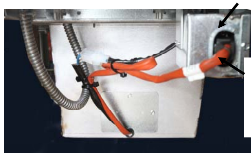
3. ábra: A képen látható módon csatlakoztassa a fekete csatlakozót a dobozhoz. A különálló, fehér dugóval ellátott kábelköteget, ha van, NEM kell használni.
